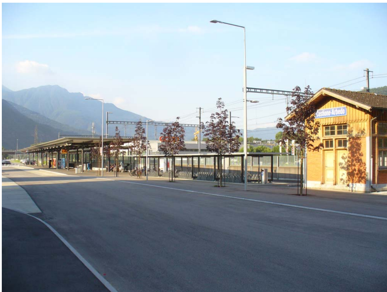
Stazione FFS Castione-Arbedo
