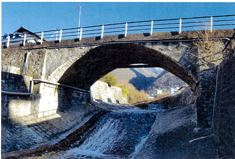
Ponte visto da Ovest
